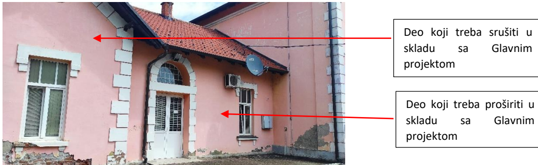
Slika 9: Železnička stanica Mataruška banja
